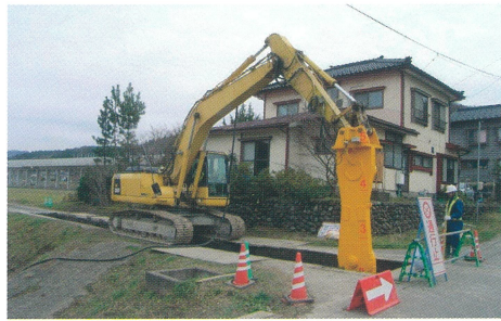
民家の近接部における改良施工
